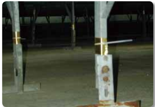
密閉設施之植床架綁銅片防止軟體動物爬行
